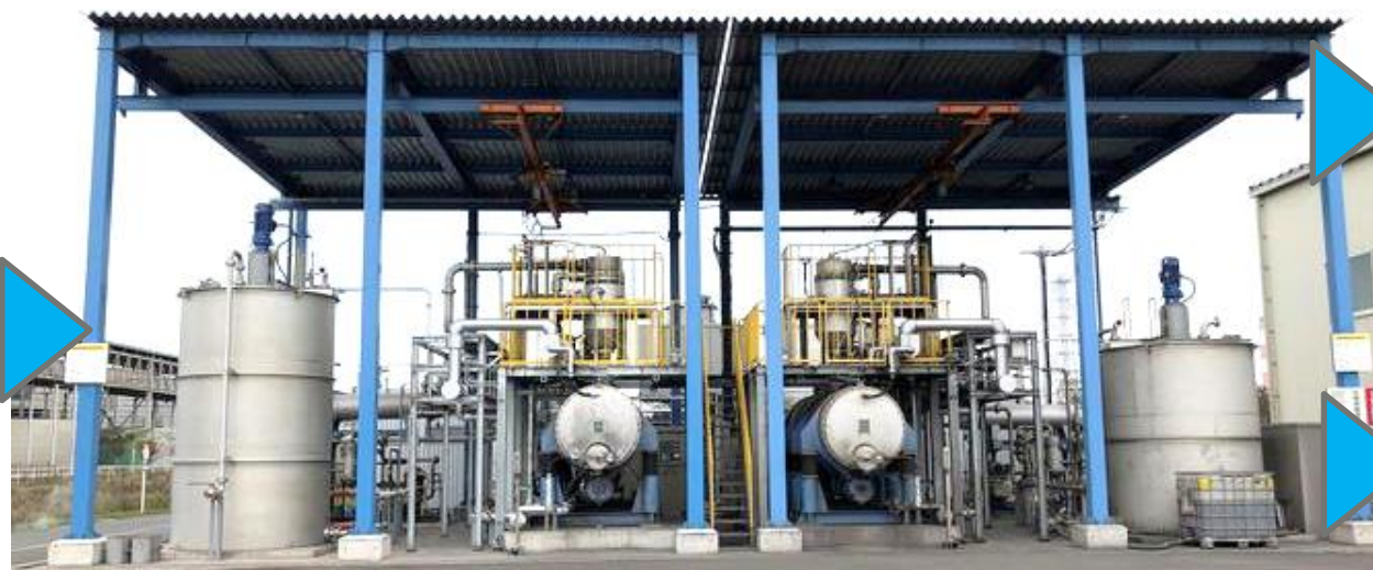
北九州循環資源製造所のリサイクル設備（減圧蒸留設備）
